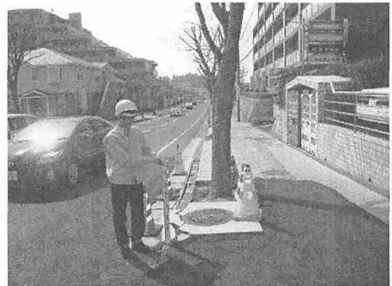
写真-22 マンホール浮き上がり
