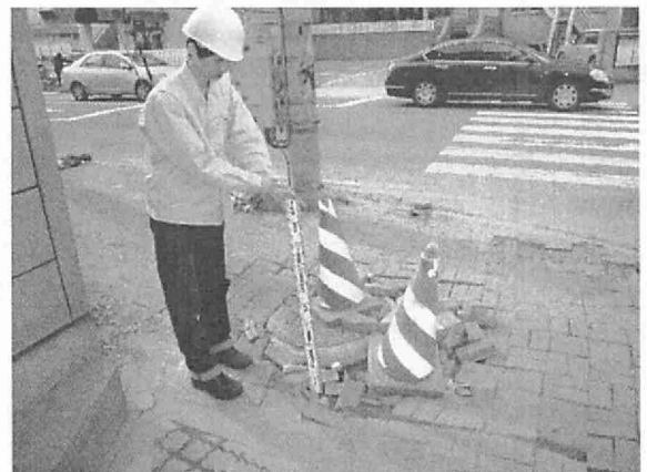
写真-1 多賀城市桜木のマンホール浮き上がり
