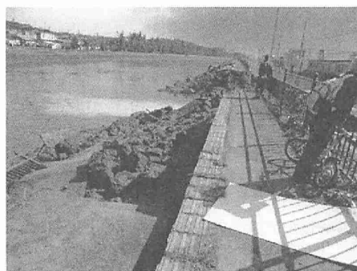
写真-11 堤防決壊部分写真 (吉田望氏撮影)
