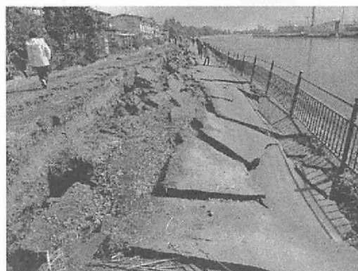
写真-12 堤防決壊部分写真 (吉田望氏撮影)
