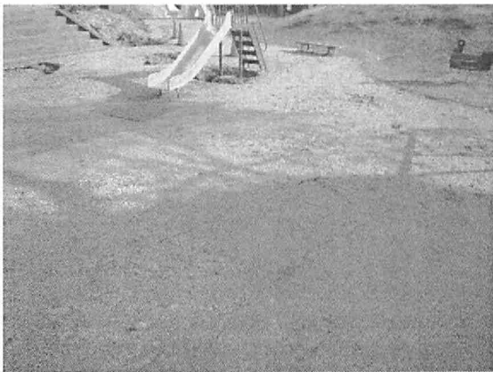
写真-26 多賀城市役所前公園地割れ
