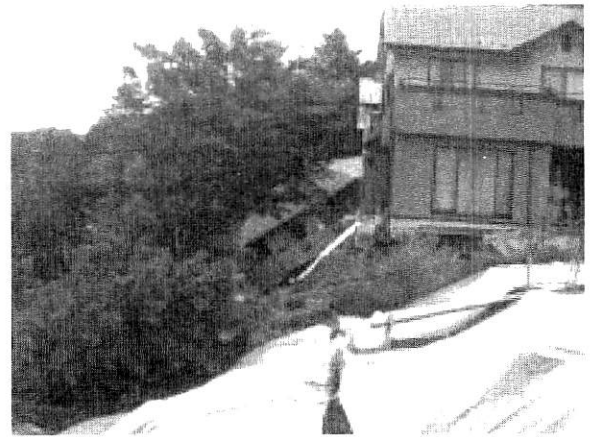
図8 西花苑地区の被害状況
