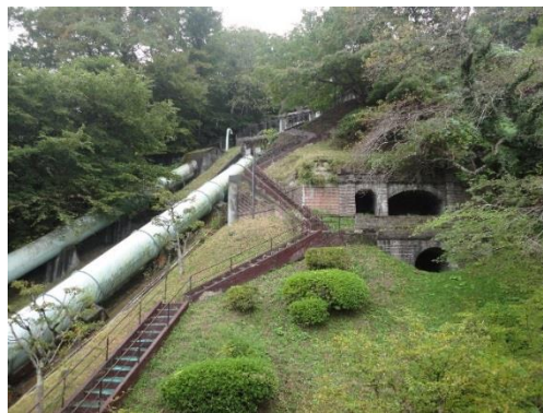
図10 三居沢発電所水路
